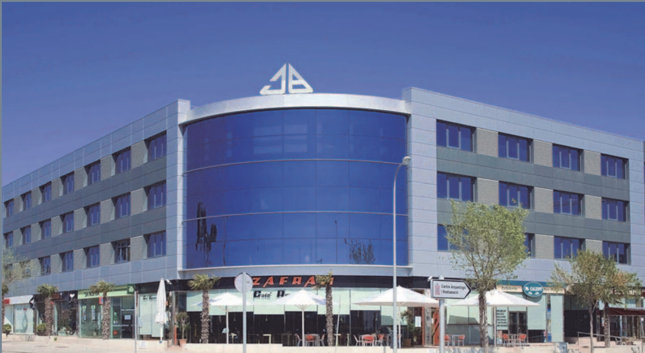
Edificio Son Rossinyol. Polígono Son Rossinyol. Palma. 2006.
