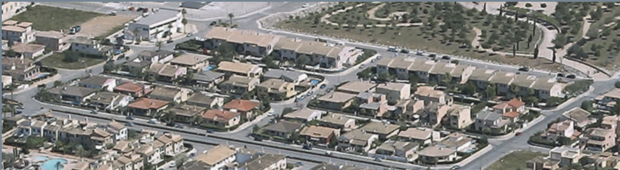
Conjunto de chalets unifamiliares y adosados, urb. Nova Cabana. Marratxí. 1992.
