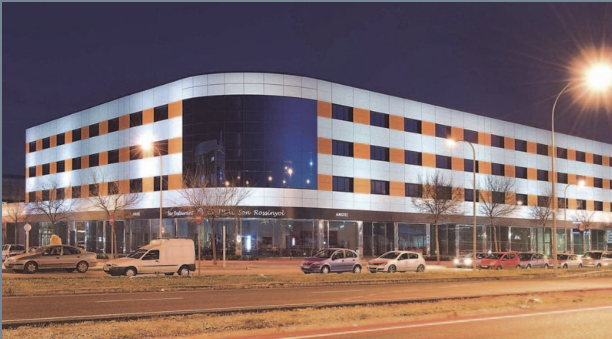
Edificio Son Rossinyol @. Polígono Son Rossinyol. Palma. 2011.
